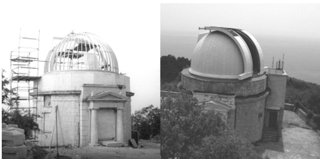
Рис. 3. Башня метрового телескопа в Симеизе в период реконструкции (1987 г.) и в настоящее время
